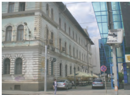
înainte de renovare
